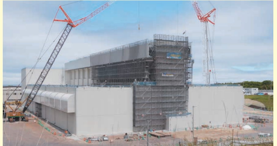
貯蔵建屋建設状況(平成25年6月)
