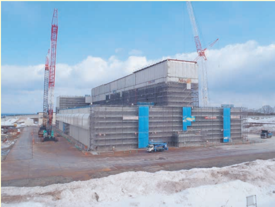
貯蔵建屋建設状況(平成25年3月)
