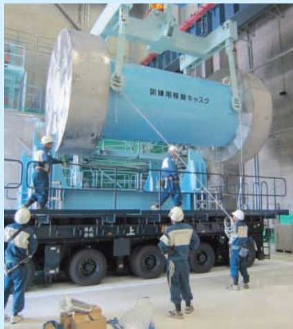
大型クレーンを用いた吊り上げ訓練
