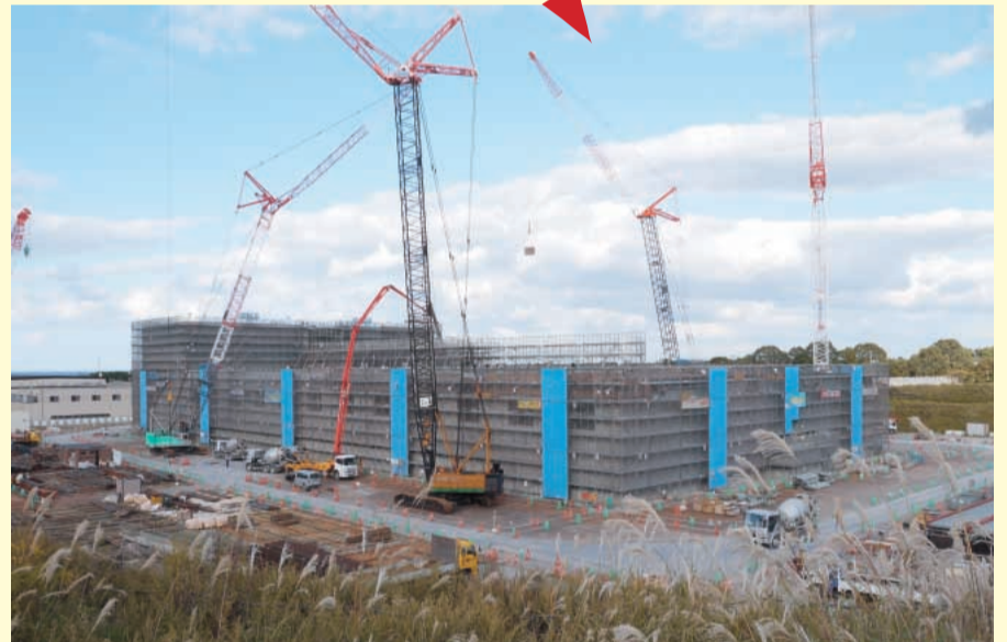
貯蔵建屋建設状況(平成24年11月)
