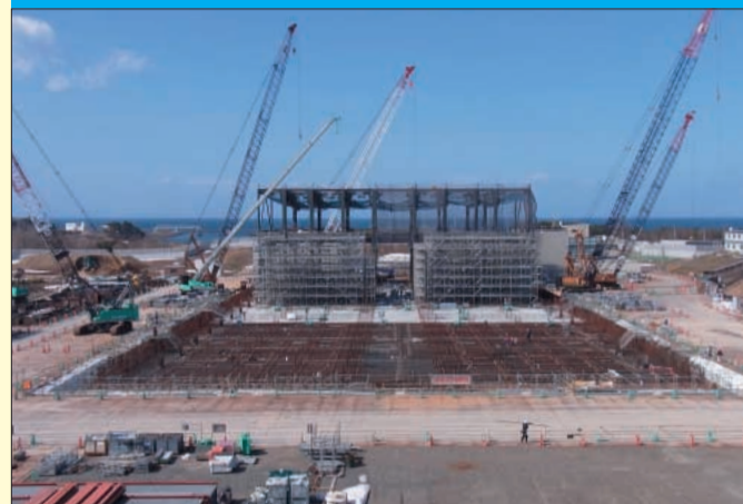
貯蔵建屋建設現場（平成24年4月）
