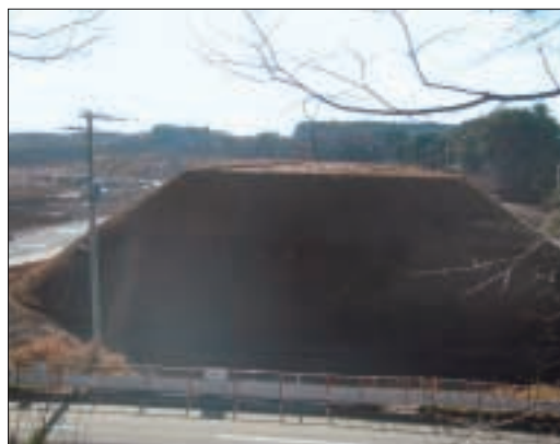
②専用道路工事
