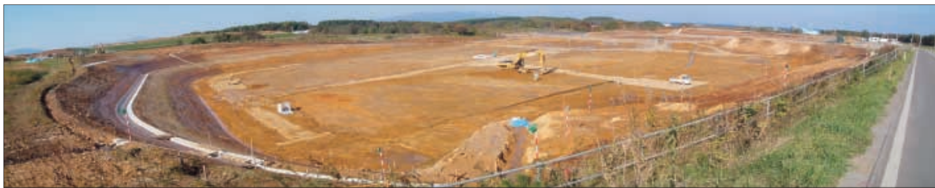
①敷地造成工事
