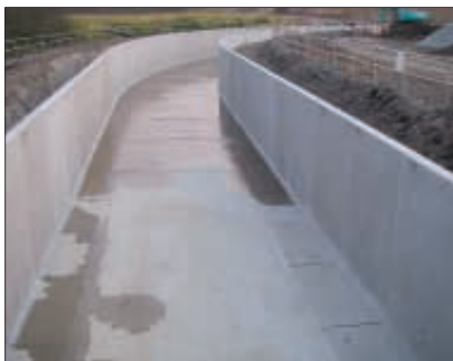
③美付川改修工事
