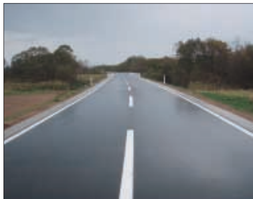
④市道付替工事
