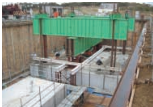
杭の載荷試験の様子
