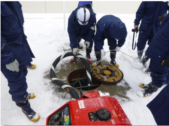
防火水槽の状況確認
