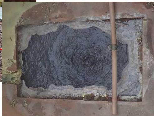
源泉槽内の状況
