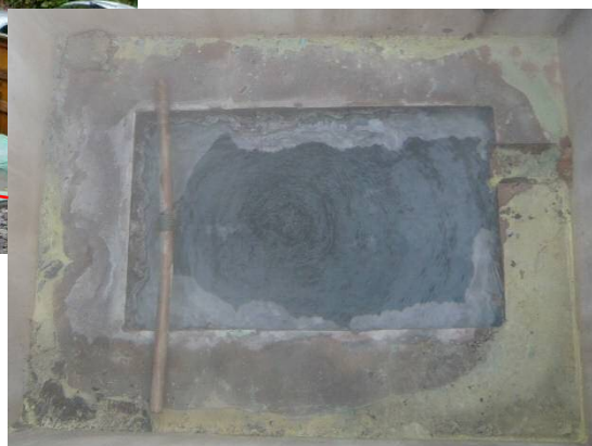
源泉槽内の状況
