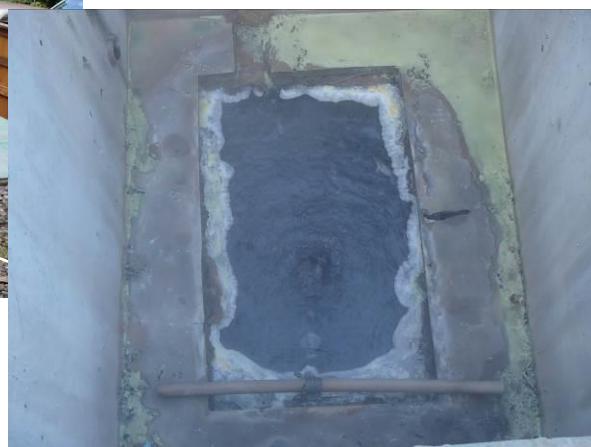
源泉槽内の状況
