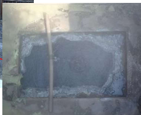
源泉槽内の状況
